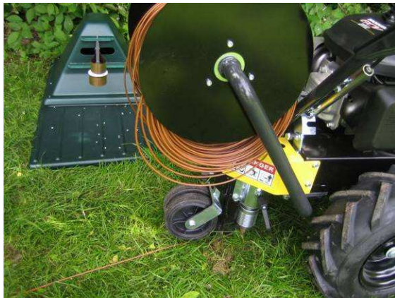
Billede 2. Maskine til nedlægning af ledning (Om-Tech Elektro)
